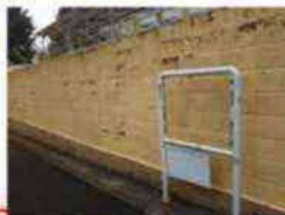
中瀬中プール南側改修前
